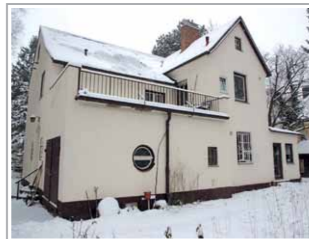
Wohnen im Wandel: Anstelle dieses einfachen und energetisch ineffizienten Nachkriegsgebäudes mit hohen Sanierungsrückständen entsteht eine hochwertige Villa mit Lebensräumen für fünf Familien.
